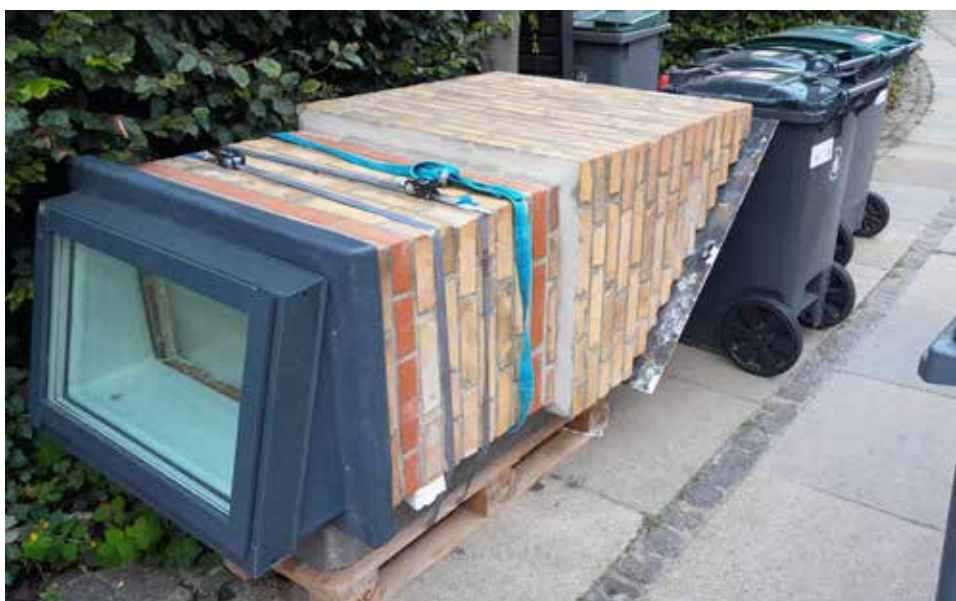
Der skal stadig være en skorsten på husets top, selvom man river den ned indvendig. En attrap skal ligne en rigtig skorsten. Her er en model med ovenlys spottet på Vesterfælledvej, inden den steg til tops. Foto: Rut, Lu 16
