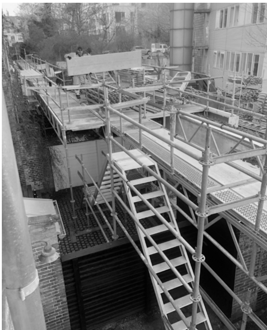
Lige nu gælder det stilladsopsætning på den længste ubrudte strækning i Humleby, Carstensgades lige numre. Der er etableret adgang via indkørslen fra Vesterfælledvej. Foto: Line
