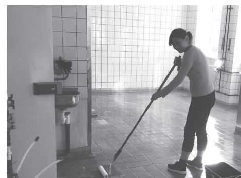
Connie vasker gulvet, inden det nye skal på.
