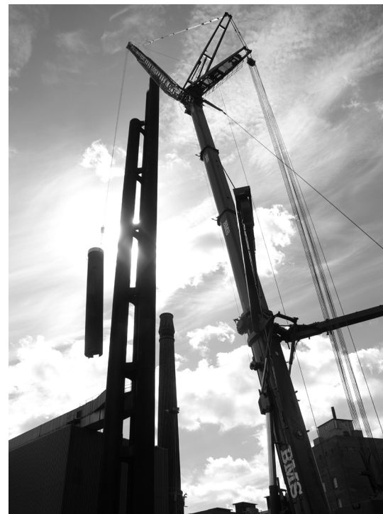
Et af kvarterets iøjnefaldende vartegn og fortrinlige lynafledere - de tre store metalskorstene ved Carlsbergs kraftværk bliver pillet ned af en kæmpekran. (Foto: Gunni).
