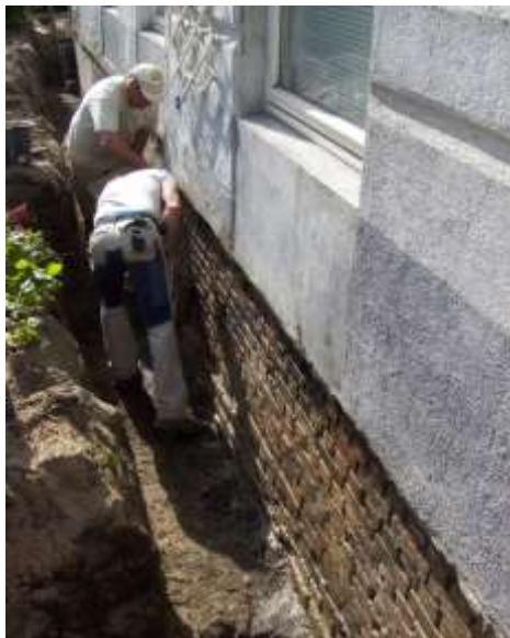
Udførsel af dræn og fugtisolering af kælderydervægge
