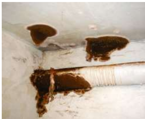
Angreb af Ægte hussvamp ( Serpula lacrymans ) i kælderdæk (kælderloft), som følge af opstigende grundfugt. Bjælkelaget over pudsen var meget nedbrudt.
