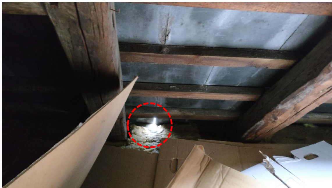
Figur 18 – Foto i tagrum. Der mangler en skifferplade. Der mangler undertag i nogle områder. Isolering ligger helt ud til undersiden af tagfladen.
