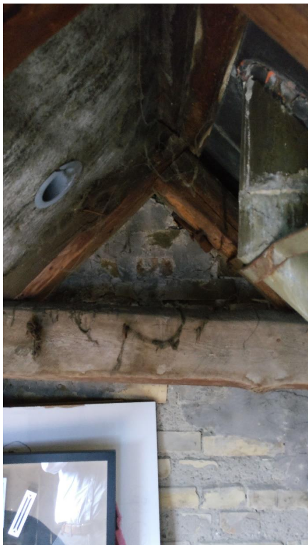
Figur 19 – Foto af undertag og ventil til ventilation af tagrummet.
