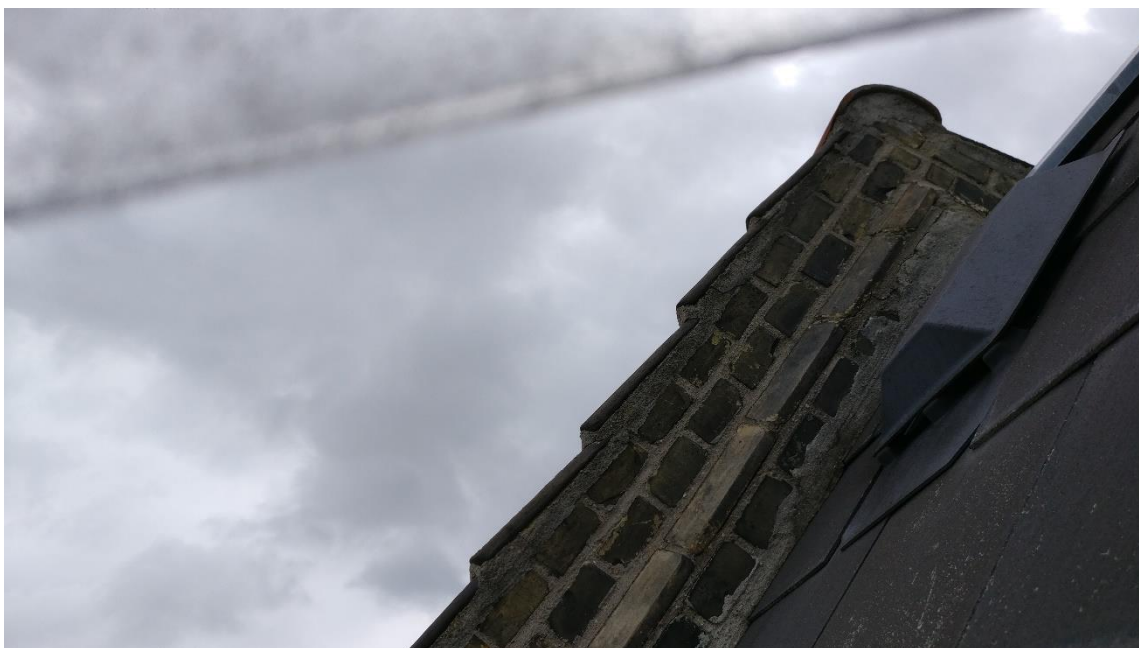
Figur 21 – Foto af brandkarm ved kip samt ventil til ventilation af tagkonstruktion.
