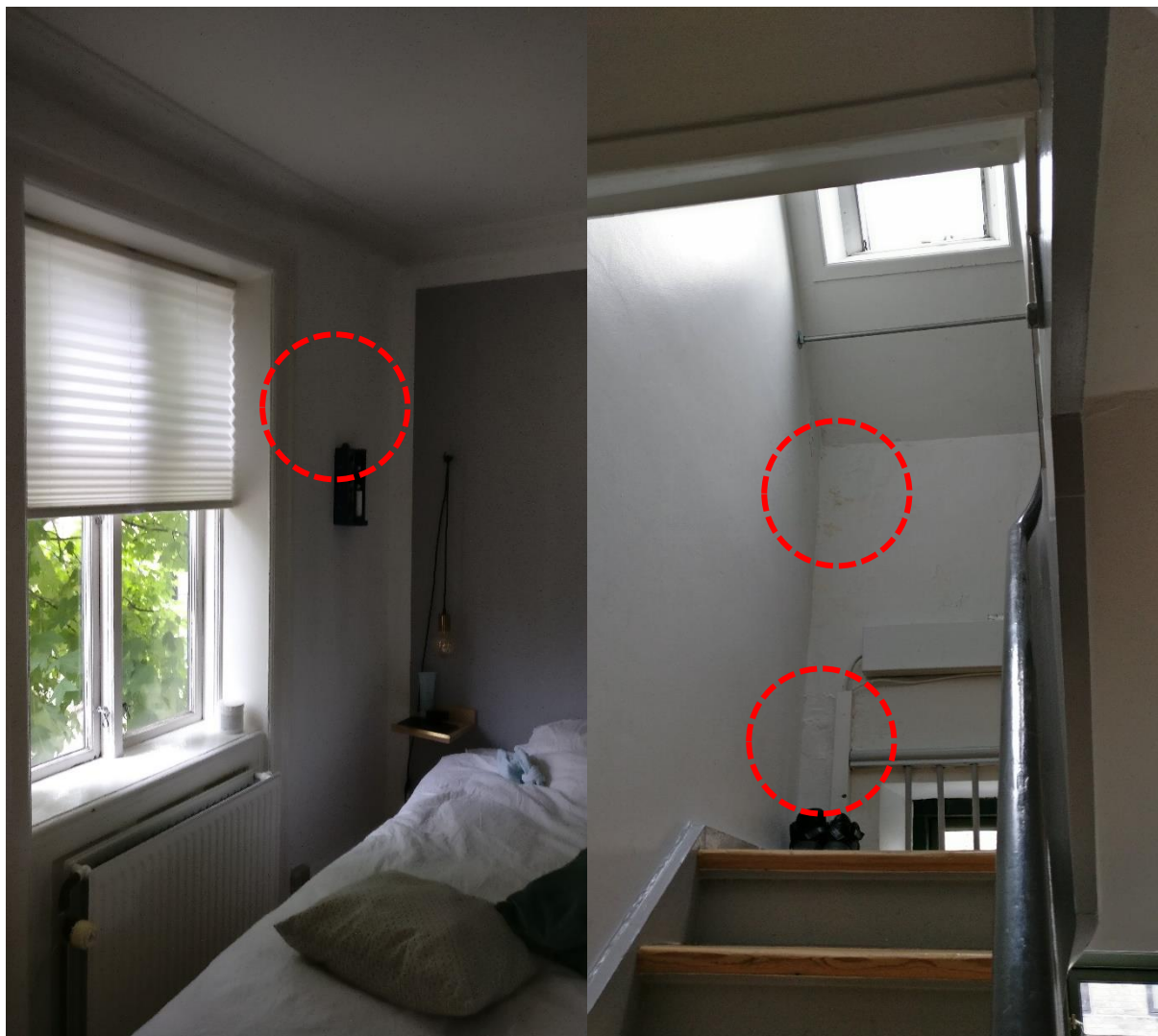
Figur 11 & 12 – Foto af værelse på 1 sal. med opfugtet væg samt foto af tapperepos mellem 1. og 2. sal, hvor der er fugtskade.
