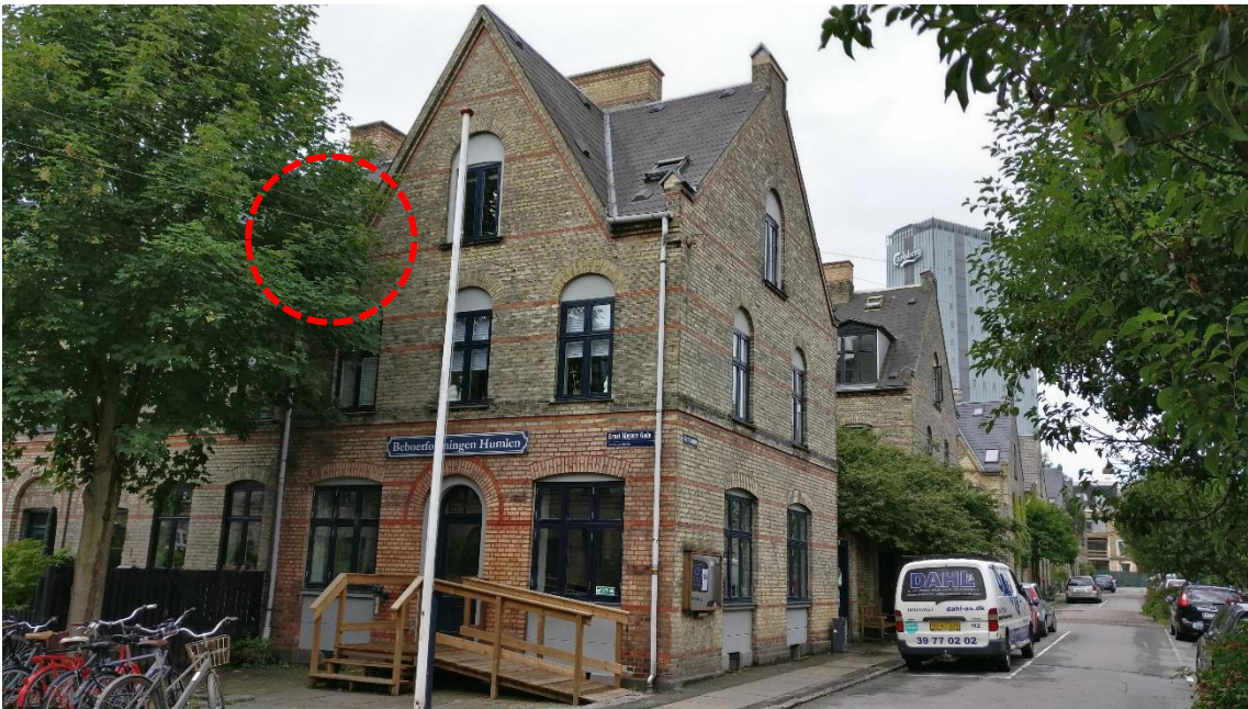
Figur 9 – Foto af facaden fra hjørnet af Carstensgade og Ernst Meyers gade.
