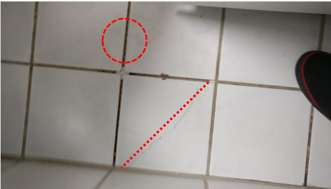
Figur 16 – Foto af knækket flise og manglende fuger på badeværelse på 2. sal.
