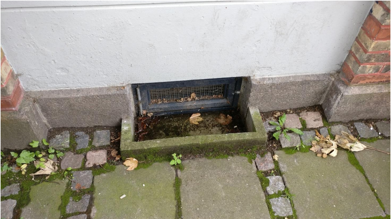
Figur 6 – Foto af kældervindue.
