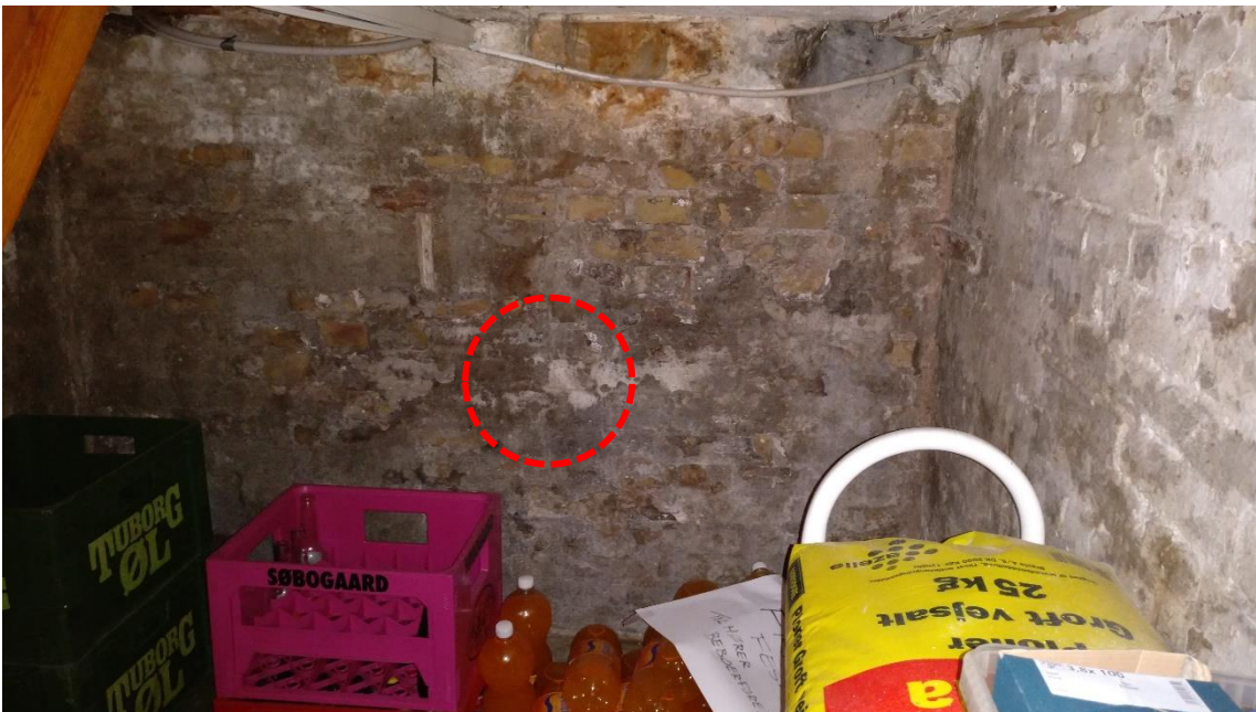
Figur 4 – Foto af opfugtet kældervæg, med saltudfældninger.
