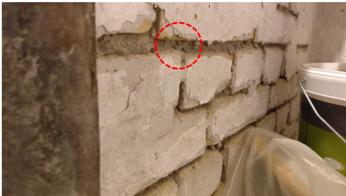
Figur 5 – Foto af kældervæg hvor mørtlen har taget skade.
