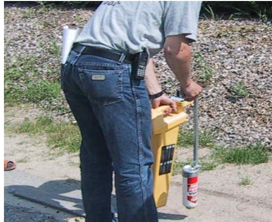
Fig. Sporing og afmærkning med ledningssøger
