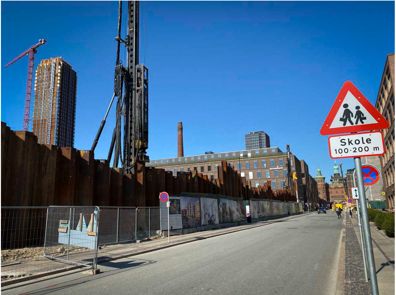
To spunsmaskiner er i gang på Ny Carlsberg Vej
