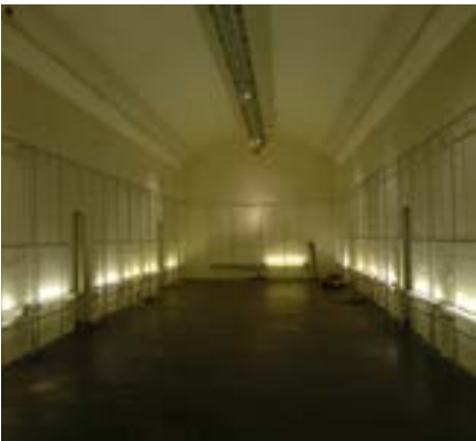
Den eksisterende kælder under pladsen.
