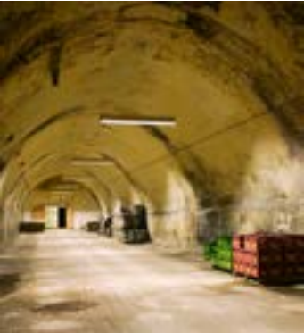
Kælderen under Rød Lagerbygning.
