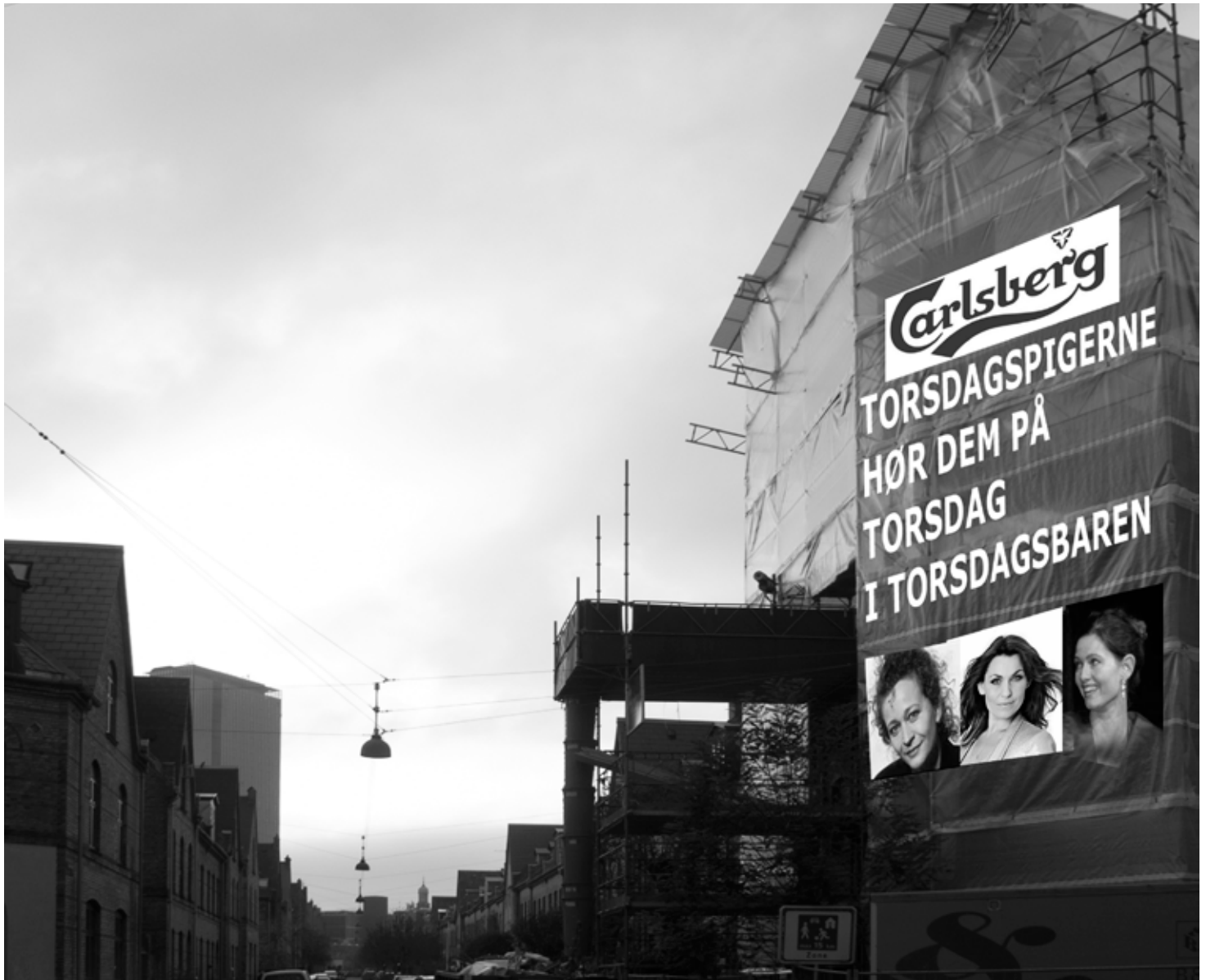
Med Ulla Henningsen, Kaya Brüel og Cille Ebling på plakaten og en solid sponsor i ryggen, mente pensionisten, at Torsdagsbarena's problemer med at få huset fyldt ville være løst en gang for alle.
